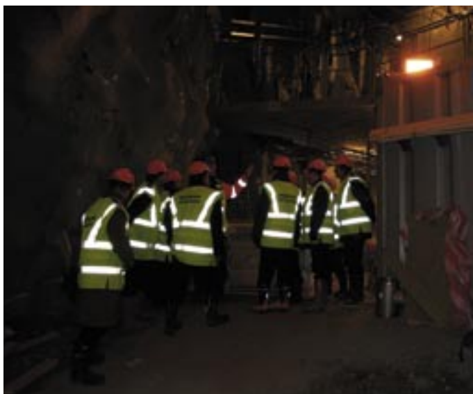
Tunnelissa oli paikka paikoin hämärää, mutta työturvallisuusasiat tuntuivat muuten olevan kunnossa ja varusteet sen mukaiset.
