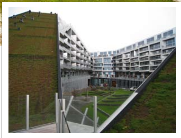
8-Tallet talossa on viherkatto, joka toimii myös rakennuksen passiivisena viilentäjänä kesäaikaan. Talo palkittiin pohjoismaisella Green Roof Award-palkinnolla v. 2010.
