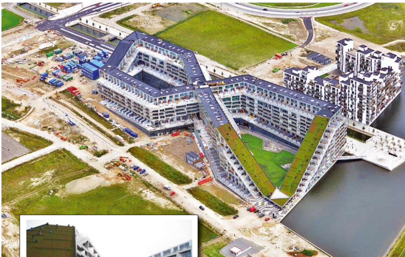
8-Tallet talossa on viherkatto, joka toimii myös rakennuksen passiivisena viilentäjänä kesäaikaan. Talo palkittiin pohjoismaisella Green Roof Award-palkinnolla v. 2010.
