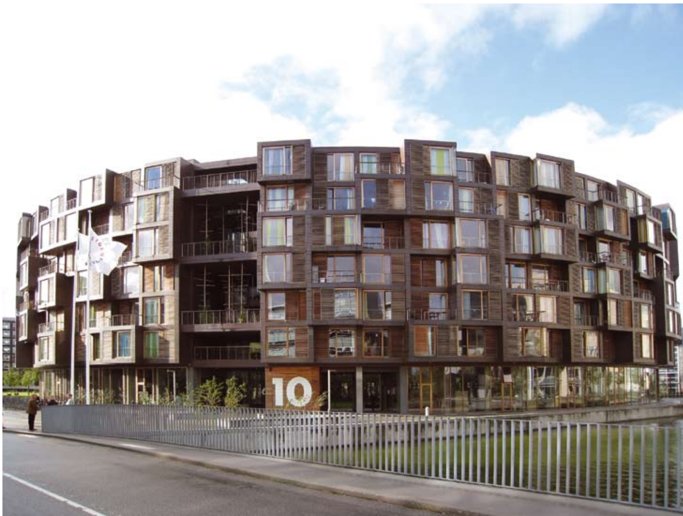
Lundgaard & Tranberg arkkitehtien suunnittelema opiskelija-asuntola Tietgen Kollegiet on saavuttanut valmistuttuaan jo useita arkkitehtuuripalkintoja. Rakennuksen erikoisuus on sen pyöreä muoto ja opiskelija-asunnoille hieman harvinaisempi kuparista ja lasista tehty julkisivu.
