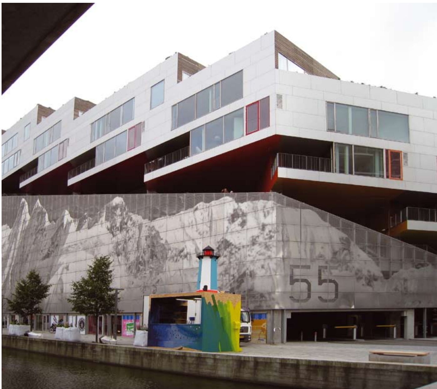
Mountain Dwellings talon pysäköintihallin seinä on tehty alumiinilevyistä, joiden Himalaja-aiheinen kuva on aikaansaatu erikokoisilla rei'ityksillä.
